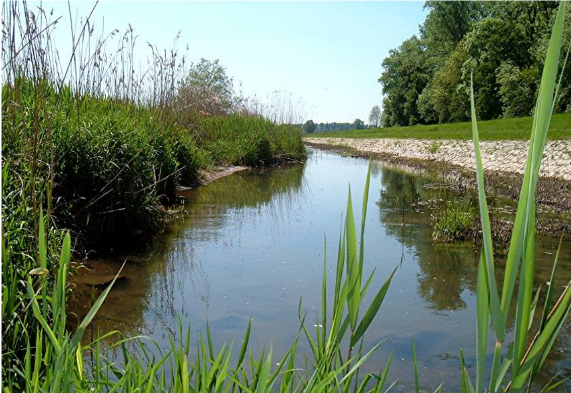
Abbildung 7: Der RFK im Mai 2009. Blick gen Süden entgegen der Fließrichtung. Die westseitige Räumung, hier rechts im Bild, gibt den Blick auf den nackten Steinversatz frei.
