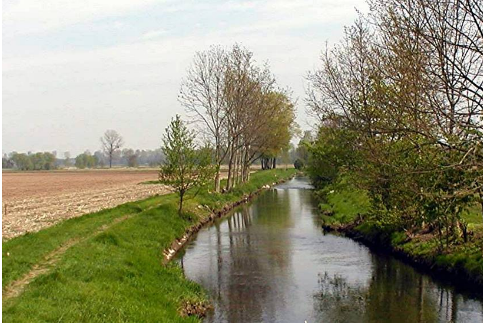
Abbildung 5: Die Alte Rench ab der Schleuse bei der Überleitung zum RFK vor der Umgestaltung (1999) mit Flussbausteinen als Uferbefestigung. Blick gen Nord-Ost in Fließrichtung (Quelle: B. Walser).
