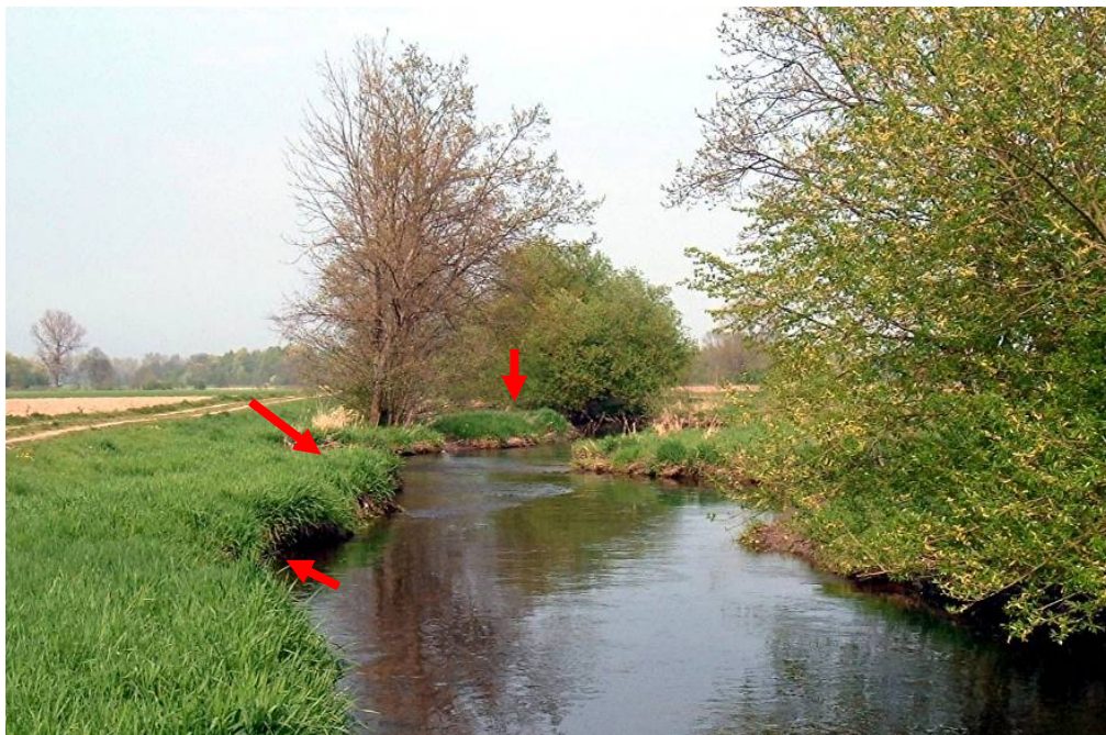
Abbildung 6: Dieselbe Stelle wie in Abb. 5 nach der Umgestaltung (04.2009). Die roten Pfeile deuten auf Strukturaufwertungen wie den geschwungenen Lauf und Anlandungen und Abbrüche.
